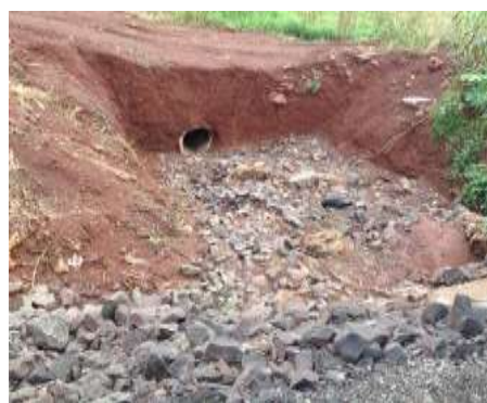
Microdrenagem da BR-163 – entrada na galeria
