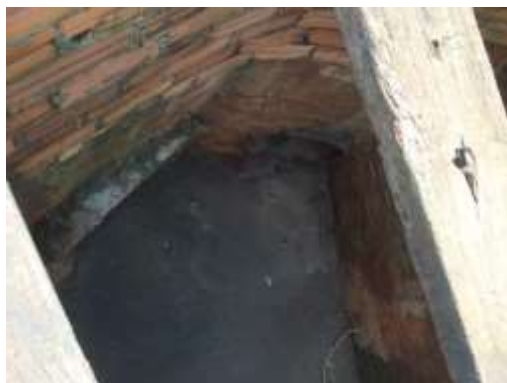
Caixa de passagem sem tampa
