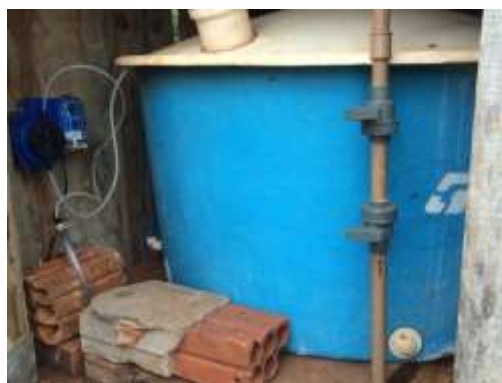
Tanque de Preparo do Cloro e Dosador
