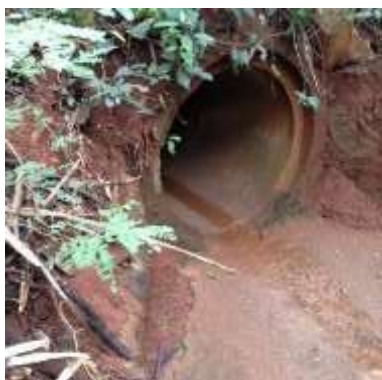
Galeria paralela à PR-239, deságue no arroio
