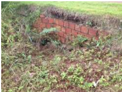
Microdrenagem com vegetação na saída
