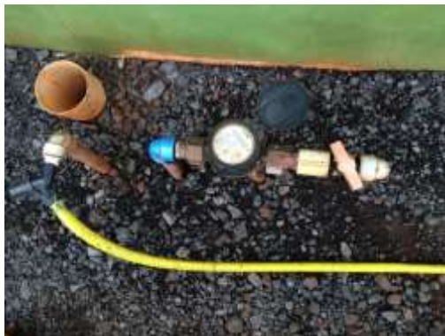
Figura 27 - Hidrômetro Linha São Vicente de Paula. Fonte: CMCPMSB, 2015.
