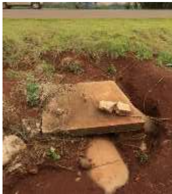
Caixa desprotegida nas laterais
