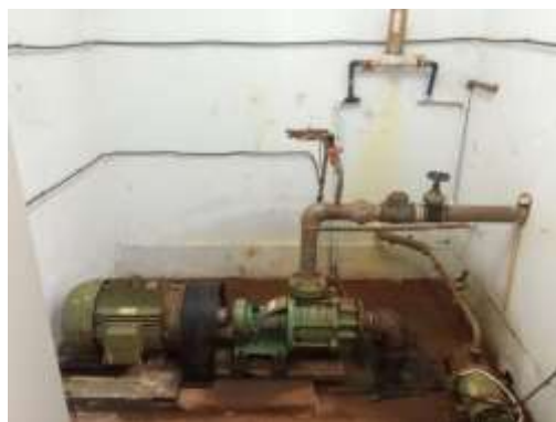
Bomba para Reservatório Elevado
