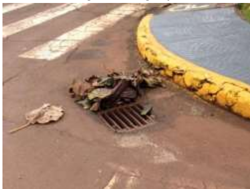
Boca de lobo com folhas atrapalhando o engolimento
