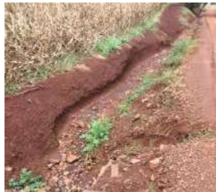
Erosão de sarjeta na lateral de estrada
