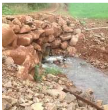
Enrocamento e microdrenagem a jusante da via
