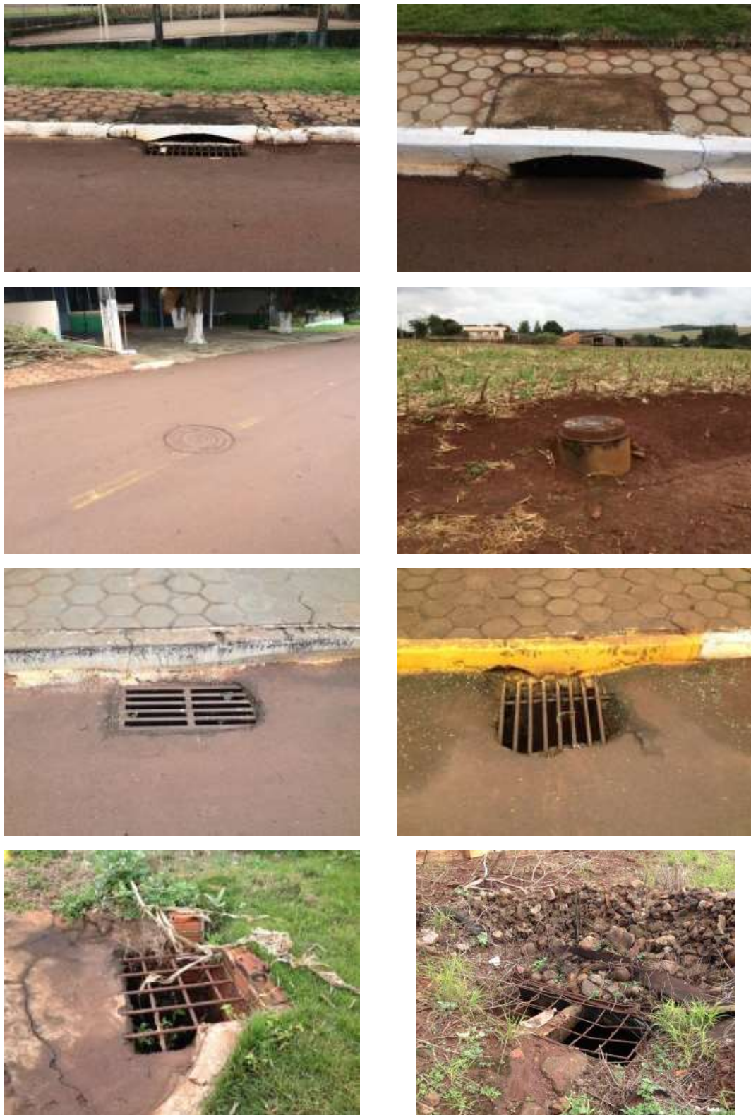
Figura 43 - Diferentes tipologias de bocas de lobo encontradas no município de Quatro Pontes. Fonte: CMCPMSB, 2015.
