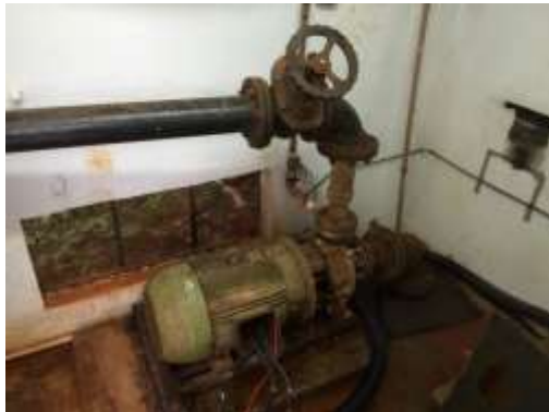
Bomba para Reservatório Elevado
