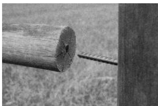
Figura 20: Trava com pino cavilha
